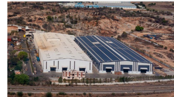
Mahabubnagar Unit-IV, Telangana
